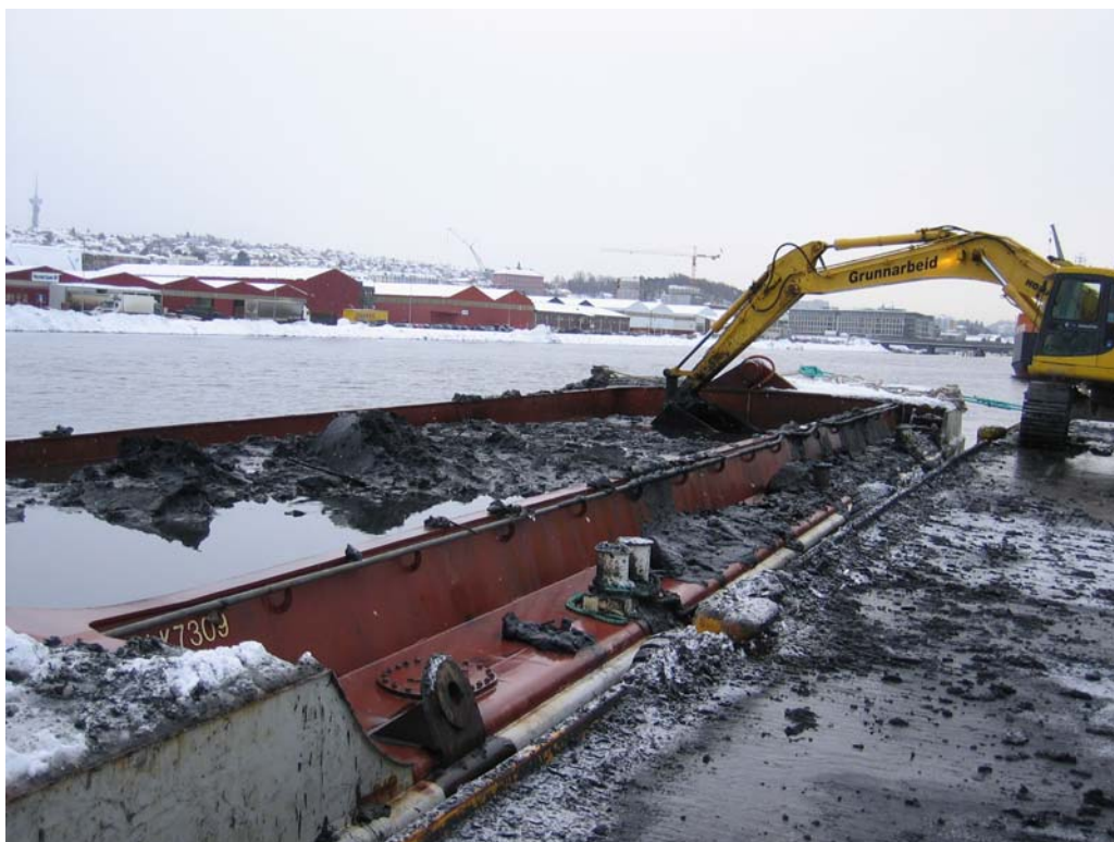
Urlastning ur pråm vid deponin
