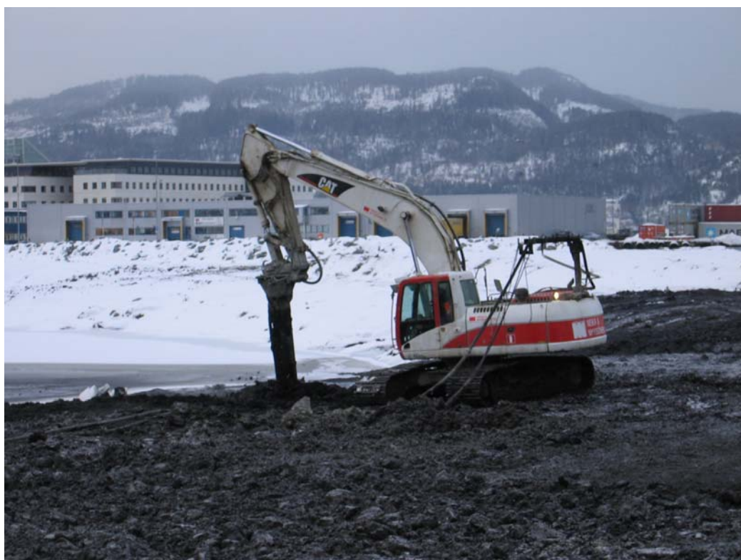
Stabilisering med skruv i deponin (via slangarna baktill på grävaren överförs additiv)
