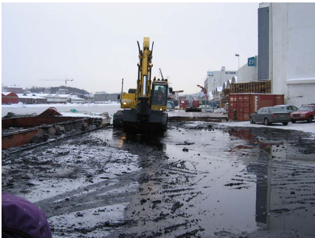
Bortsortering av skrot mm samt passiv avvattning
