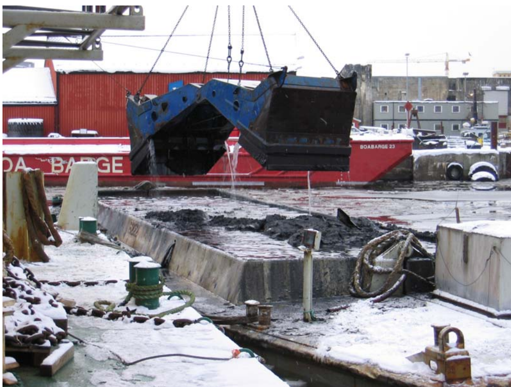
Skopan töms i (överfylld) pråm
