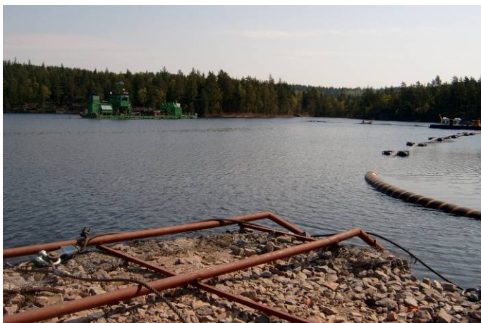
Figur 7 Exempel på sugmuddring med pumpledning till land (t.v.) och avvattningsanläggning för mekanisk avvattning samt vattenrening (t.h.)
